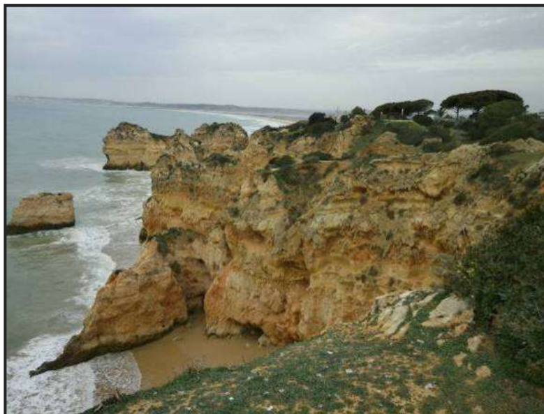
Figura 5.3.4 – Vista sobre a falésia (no sentido Oeste), junto à piscina do Aldeamento da Prinha. Observa-se uma zona de enseada com acumulação de areias de praia.
